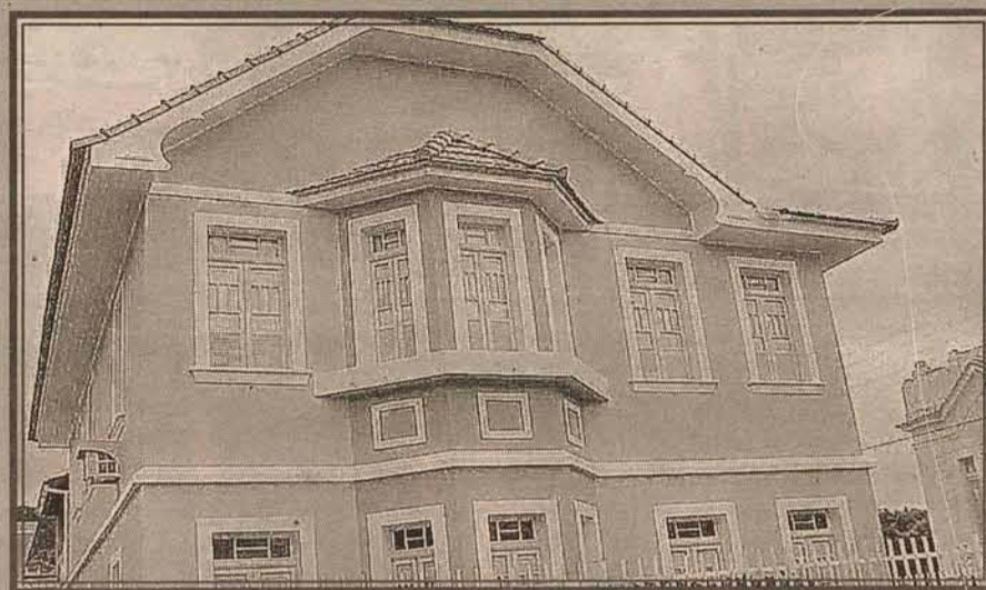
Estilo Colonial Inglês, arquitetura largamente utilizada nos Estados Unidos. Em primeiro plano destaca-se uma Bay-Window. Edificação situada entre as ruas Barão do Rio Branco e Duque de Caxias.
